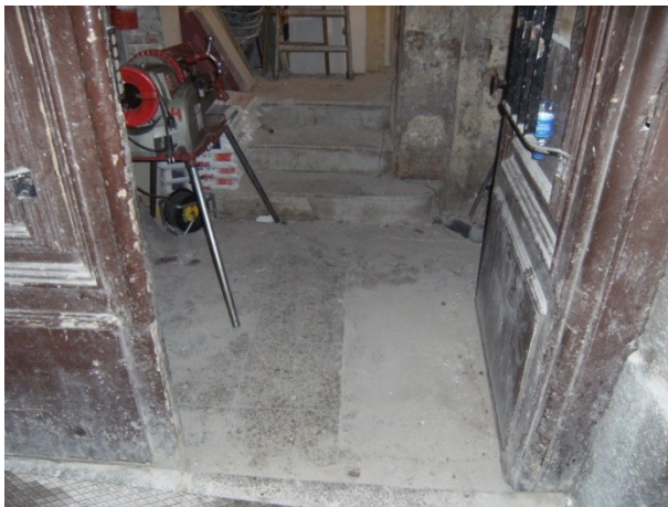
FOTO 3. Vestíbol de l'immoble abans de la intervenció
