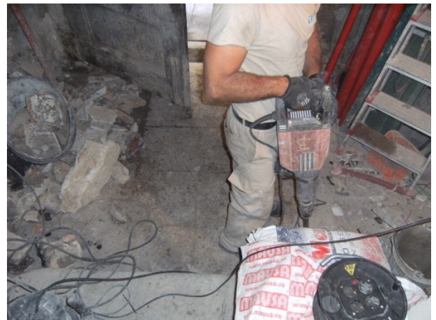
FOTO 4. Inicis de les tasques d'excavació
